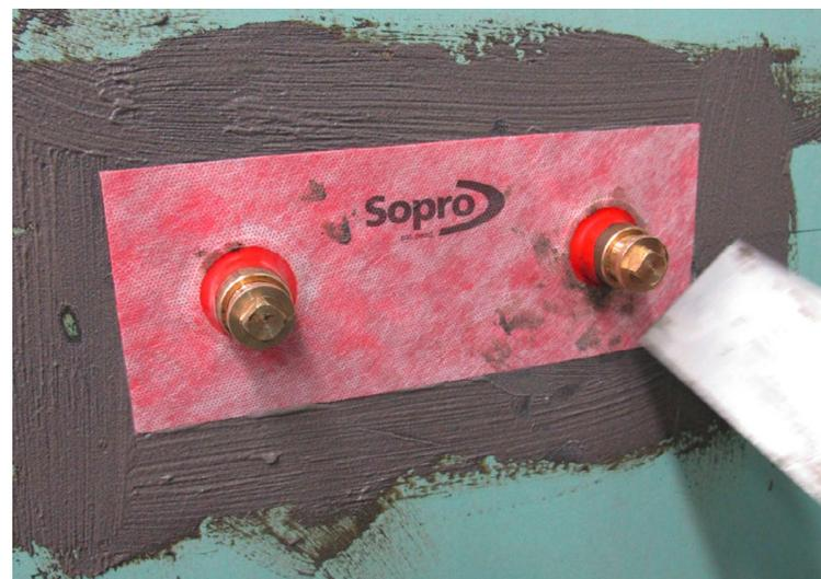
Eindichten von Rohren für Wasserhähne und Aufputzarmaturen mittels Sopro-Dichtmanschetten.
