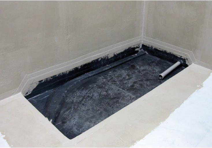
Zum anderen der Einsatz von Wannendichtbandlösungen, welche am Wannrand angeklebt werden und in das Verbund-Abdichtungssystem an Wand und Boden eingearbeitet werden.
